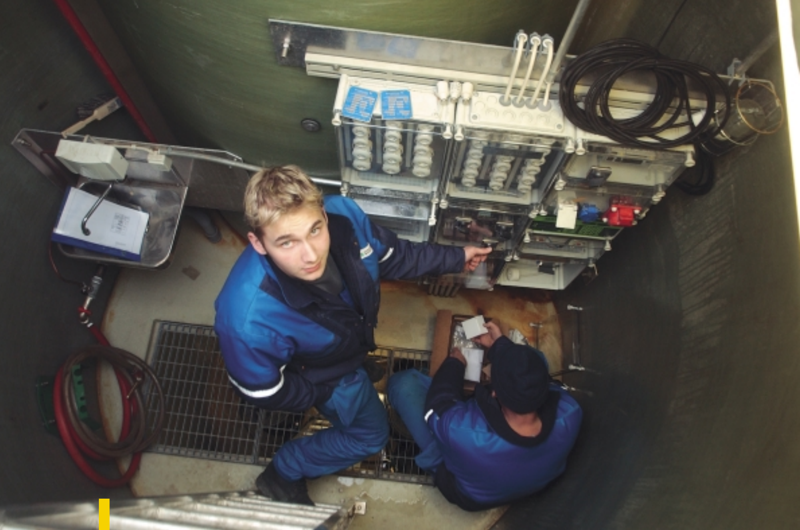
Jonas Finnbäck asentamassa sähkökeskusta.
