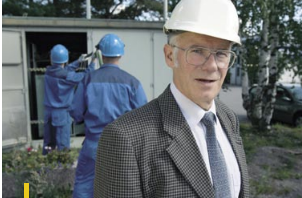
Verkställande direktör för Borgå Elnät Ab Göran Ahlskog följer med underhållsarbetet i en strömförande transformator.
